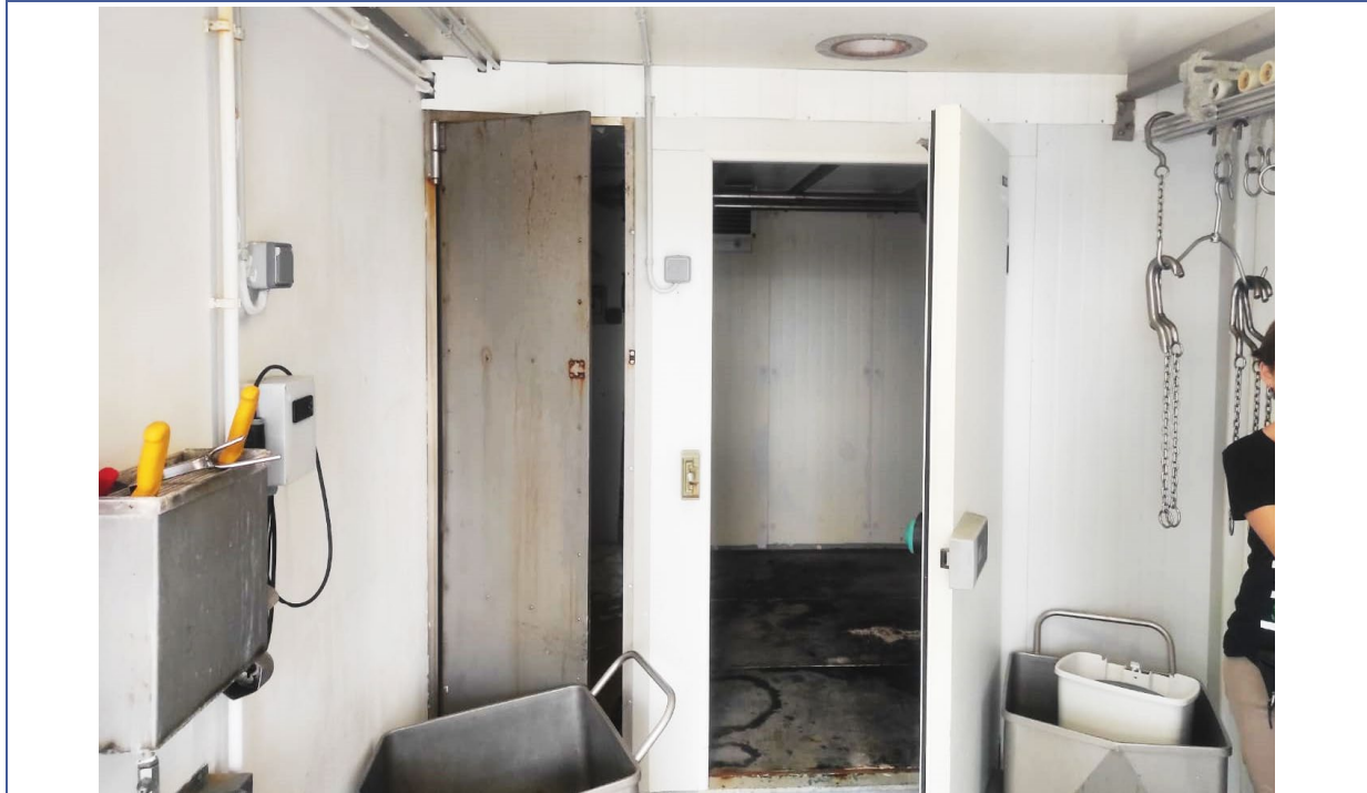
Fotografía 4: Vista de la zona limpia, equipada con guía (viene de la zona sucia), carros para la recogida de vísceras y pieles, esterilizador de cuchillos y lavabo (no se ve en la foto). Al fondo puertas de acceso al almacén (izquierda) y a cámara frigorífica (derecha) .
