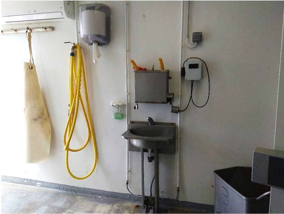
Fotografía 7: Equipamiento de la zona limpia: aire acondicionado, esterilizador de cuchillos, lavabo de accionamiento a pedal con jabón, punto de agua con manguera, soporte para rollo de papel , perchero para la ropa de faenado y recipiente para la recogida de pieles y vísceras.
