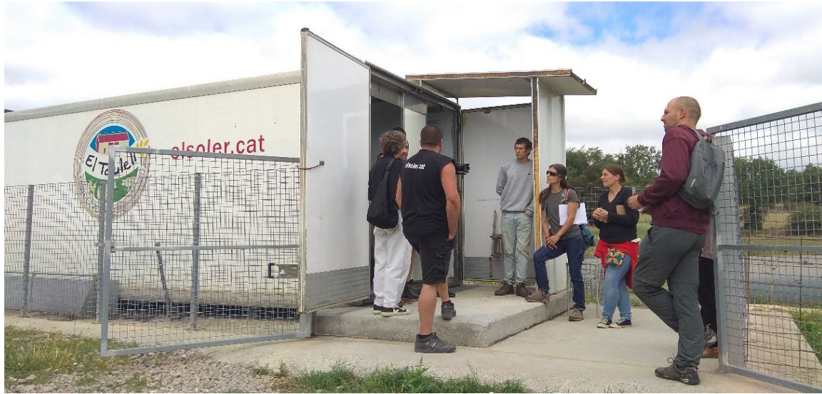
Fotografía 1: Vista exterior del matadero en finca durante la visita, construido en una caja de camión y apoyado sobre solera de hormigón.
