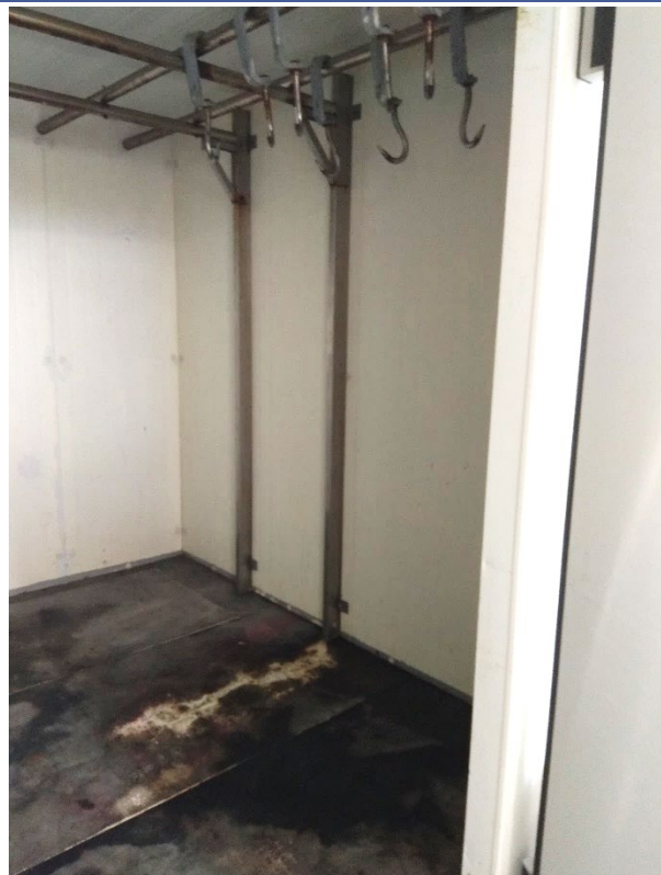
Fotografía 6: Interior de la cámara frigorífica.
