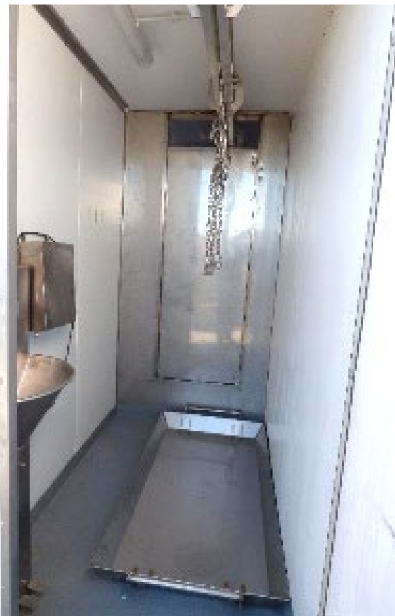
Fotografías 2 y 3: Zona sucia vista desde el exterior e interior respectivamente, equipada con guía en el techo, lavabo de pedal, esterilizador de cuchillos y cubeta de recogida de sangre. En la Fotografía 2, al fondo, se ve la puerta que separa la zona sucia de la limpia. En la fotografía 3, al fondo se ve el reposacabezas situado en la zona exterior.
