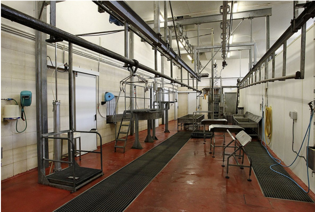
Fotografía 4: Vista de la zona de faenado: líneas de vacuno y equino (izquierda) y de ovino y caprino (derecha).
