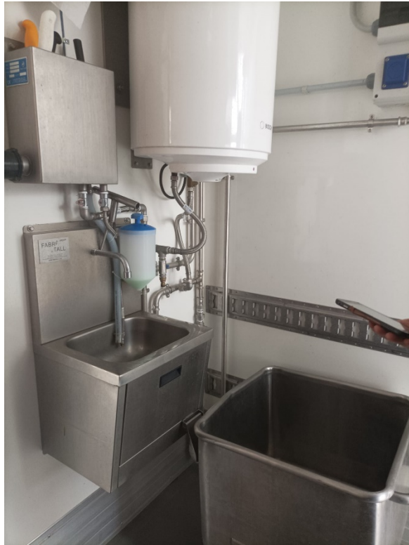
Fotografía 10: Equipamiento de la zona limpia: termo para calentar agua, esterilizador de cuchillos, lavabo con jabón y recipiente para la recogida de pieles y vísceras.
